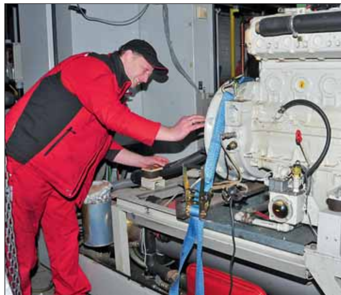
Rainer Schäfer baute mit Unterstützung einer Firma aus Sachsen den neuen Generator in das Blockheizkraftwerk ein.
