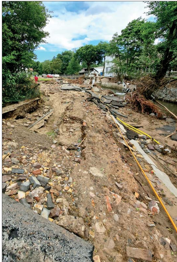
Komplette Straßen spülte die Flutwelle in der Eifel weg. Wochentlang gab es keine Infrastruktur mehr. Balver THW-Helfer waren eine Woche im Katastrophengebiet.
