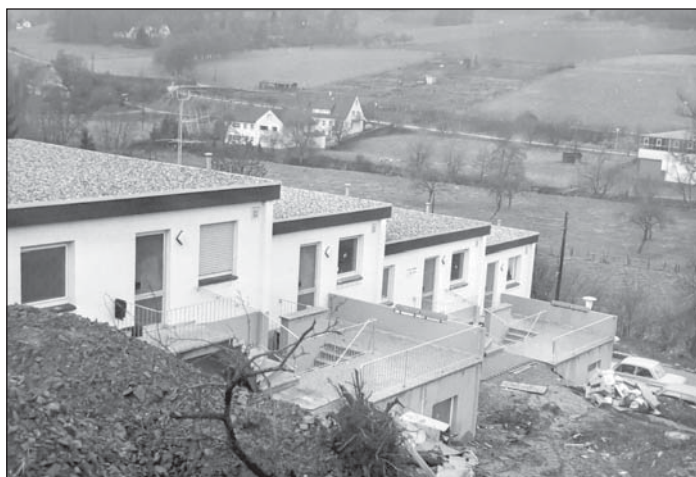
Bauarbeiten an den Häusern in der Hauschlade mit Blick in Richtung In der Amecke.
