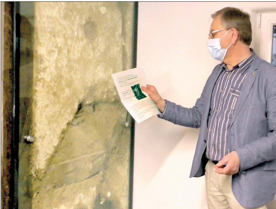
Michael Bathe vor dem freigelegten Mauerwerk in der oberen Etage des Hauses.
