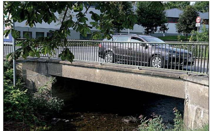
Die Brücke für die Zufahrt zur Balver Höhle (Helle 2, in Balve) wird aufgrund des schlechten baulichen Zustandes saniert. Im Zuge der Sanierung erfolgt auch eine Erneuerung der seitlichen Brückenkappen. Die südliche Kappe mit dem Gehweg wird dabei verbreitert um die Sicherheit für den Fußgängerverkehr zu verbessern.
