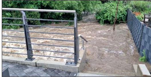
Die Hönne am Netto erwies sich als Hindernis beim Hönne-Hochwasser. Foto: Daniel Pütz
