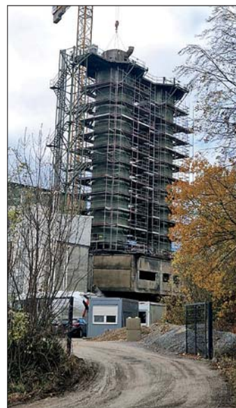
Die Öfen wurden für den Rückbau eingerüstet. DP
