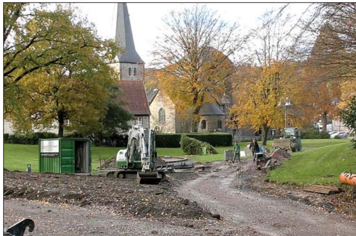
Der erste Bauabschnitt soll noch vor Weihnachten beendet sein.
