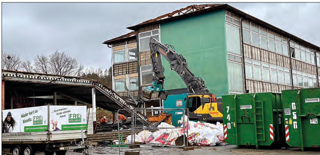
Nach der Entkernung und Beseitigung des Asbests beginnen die Abbrucharbeiten. Fotos: Krahl
