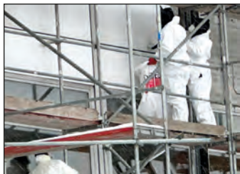
Asbestbeseitigung unter extremen Schutzmaßnahmen.
