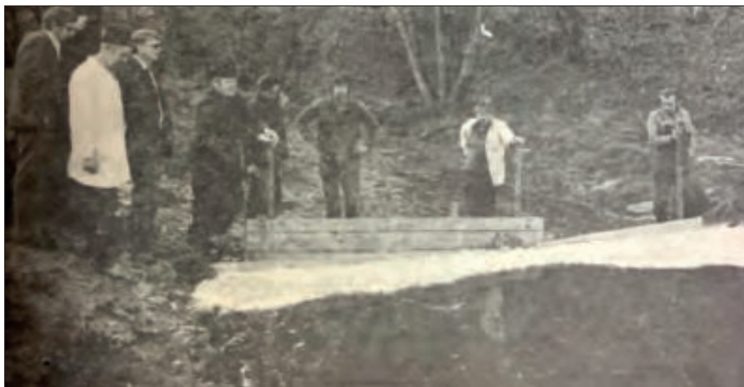
Eine Ölsperre wurde schnell unterhalb der Schadensstelle von der Freiwilligen Feuerwehr Balve errichtet.
