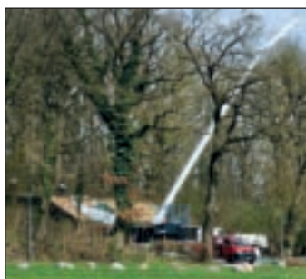
Die SGV-Mitglieder decken das Dach des Vereinsheims neu.
