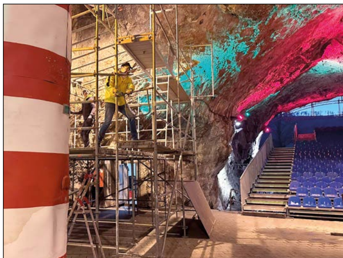
Im Moment wird das Gerippe für die Burg gebaut, in dem der Sheriff sein Unwesen treibt. Foto: Roland Krahl
